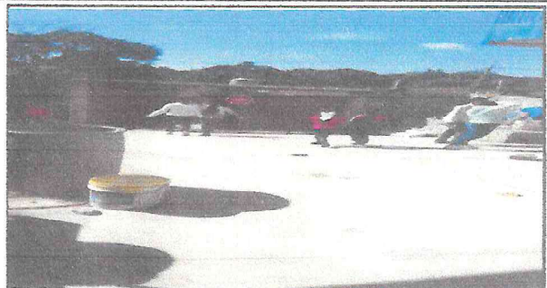
Foto 2: Losa de patio terminada
