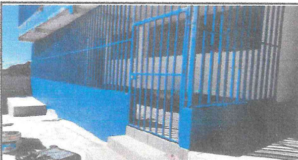
Foto 3: Barandal en pasillo inferior colocado
