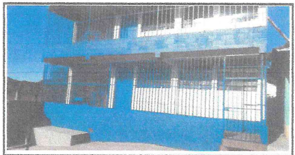
Foto 6: Pintura en muros finalizada
